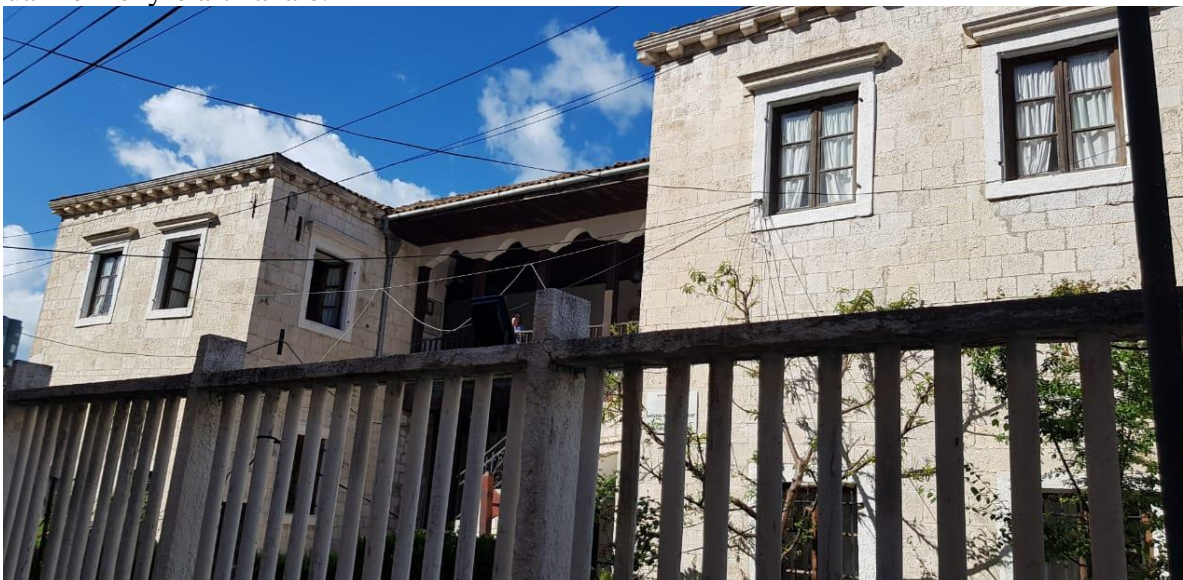
Foto e realizuar në objekt para tërmetit
