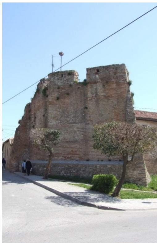
Foto e realizuar në objekt para tërmetit
